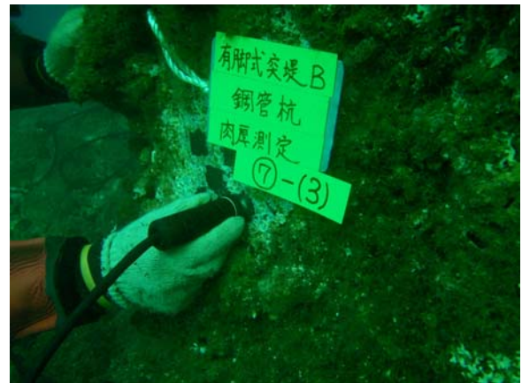
鋼管杭の肉厚調査状況(水中)
