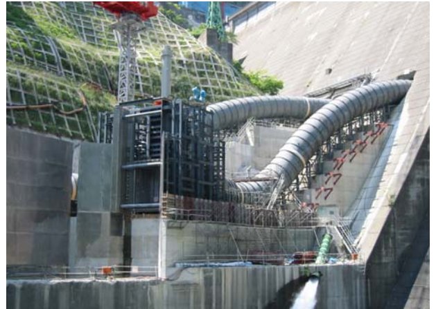
新設放流管および高圧スライドゲート設置状況
