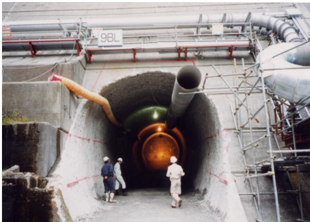
堤体削孔状況
