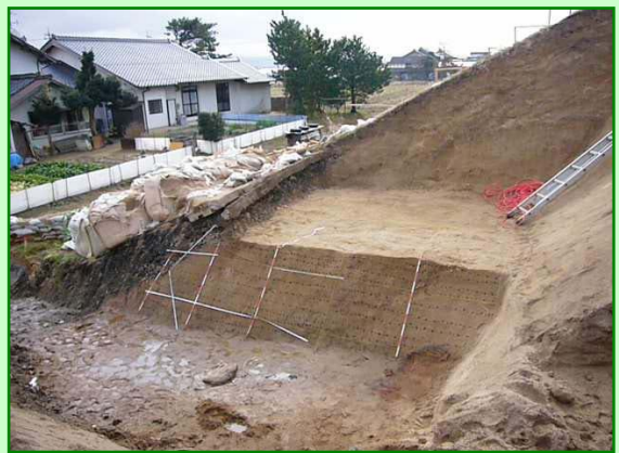
堤防開削調査の事例（平成 19 年 1 月 斐伊川）
